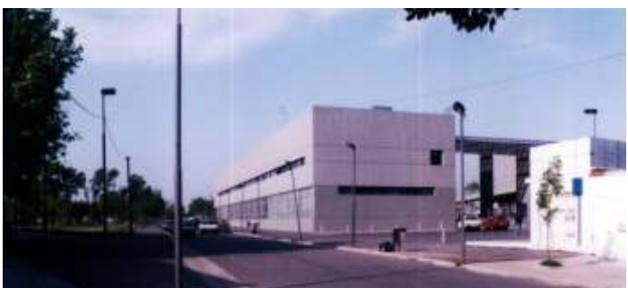
CMDO: Vista desde calle P. Rosas
